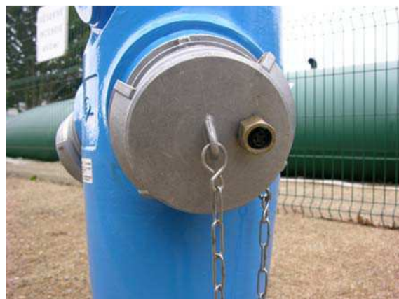
Poteau d'aspiration de 150 mm muni d'un Airclap
